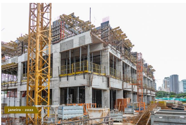
Foto 4 – Visão lateral de obra com formas de concreto armado
