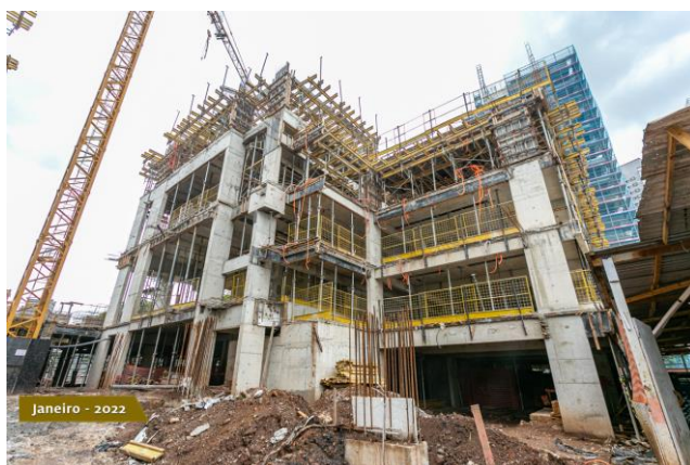
Foto 3 – Montagem de formas no quarto pavimento para concretagem de estrutura em concreto armado
