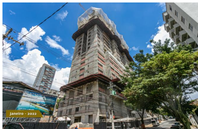
Foto 1 - Fachada do edifício
