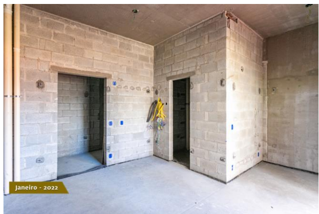
Foto 3 - Conduítes elétricos em alvenaria.
