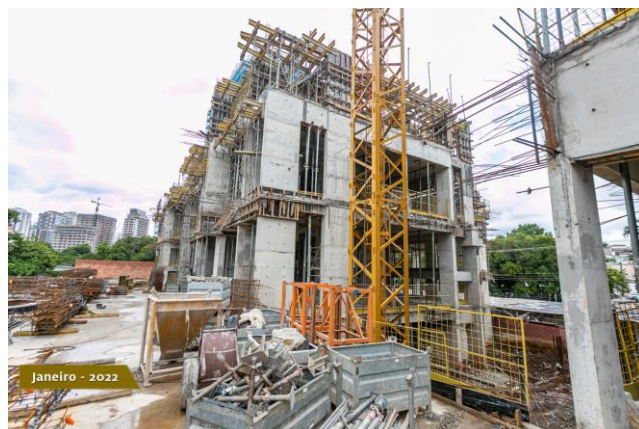
Foto 2 – Pilares em concreto armado do primeiro pavimento acabados
