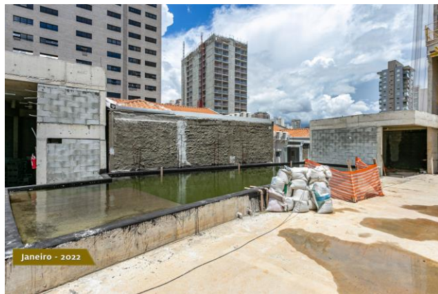
Foto 4 – Impermeabilização de piscina em área de lazer
