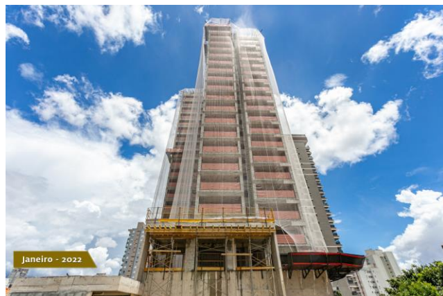
Foto 3 - Fachada do empreendimento com 20 pavimentos construídos.
