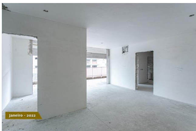
Foto 1 -Paredes de pavimento em dry wall e contrapiso finalizado.
