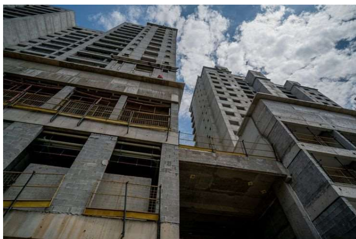
Foto 1 - Vista frontal da obra.
