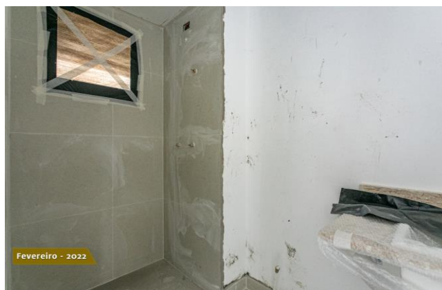
Foto 2 – Paredes com acabamento em área molhada de unidade.
