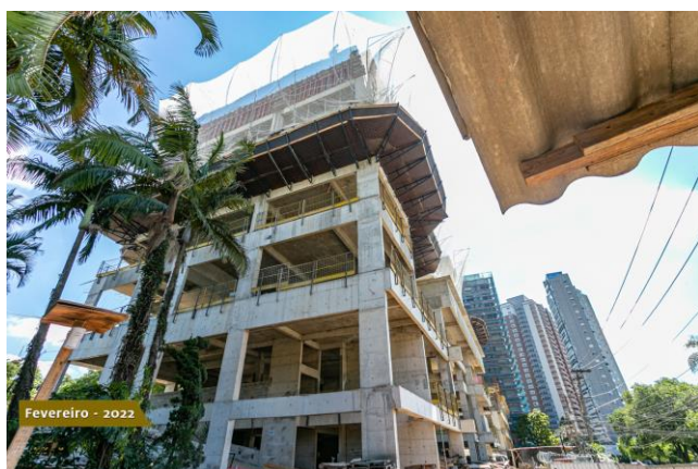
Foto 4 – Visão lateral de obra com primeiros pavimentos concretados.
