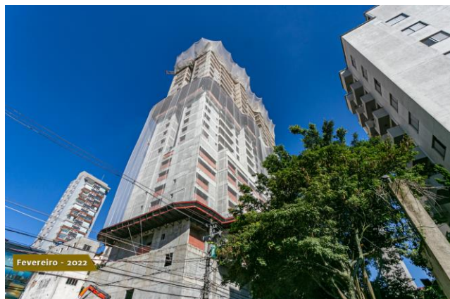
Foto 1 - Fachada do edifício
