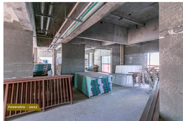
Foto 4 – Pavimento térreo com revestimentos e grades alocados em obra.
