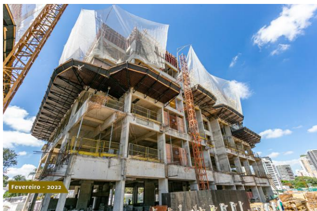
Foto 2 – Formas de estrutura montadas em quinto pavimento.
