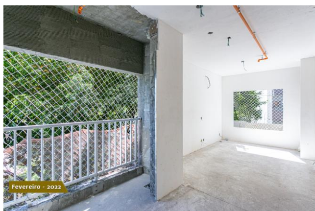
Foto 1 – Parapeito de sacada, paredes revestidas com massa corrida e contrapiso finalizado em pavimento.
