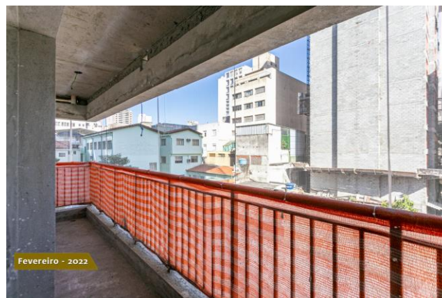
Foto 4 - Parapeito de sacada instalada em pavimento
