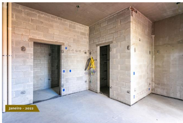
Foto 3 - Conduítes elétricos em alvenaria.
