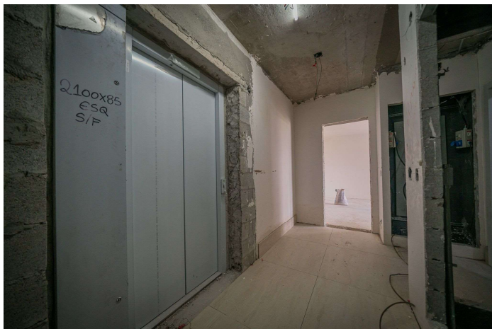
Foto 3 – Acabamentos em área comum de elevadores.
