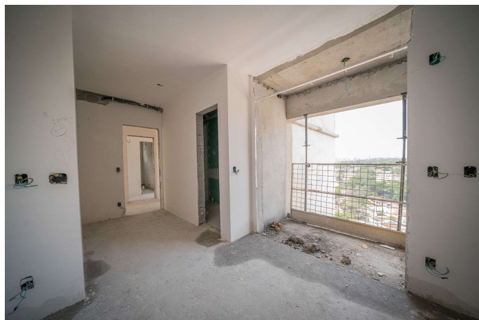
Foto 2 – Área interna de unidade não residencial.
