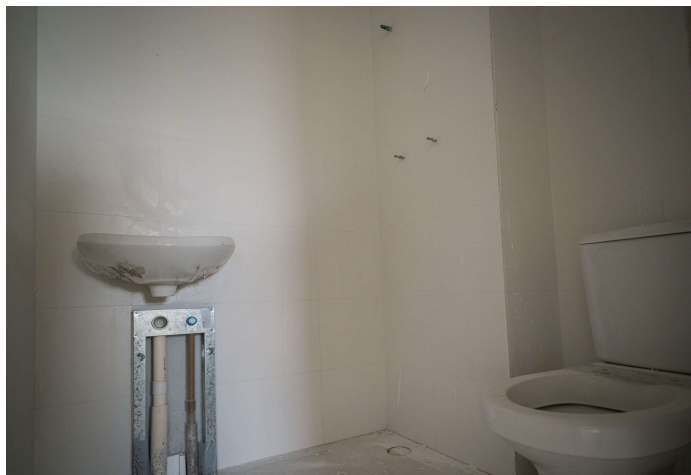
Foto 4 – Acabamento em área molhada de unidade.
