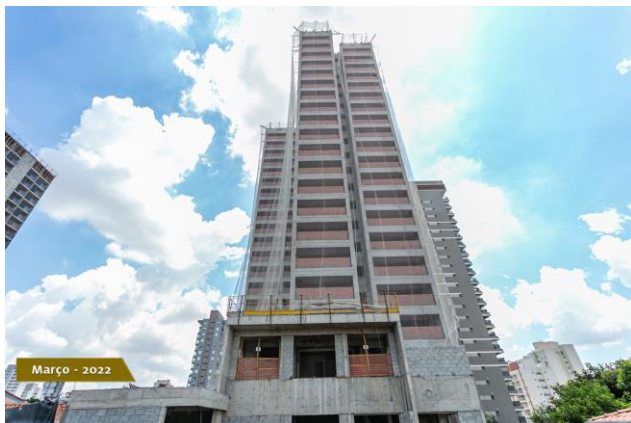
Foto 3 - Fachada do empreendimento com 20 pavimentos construídos.
