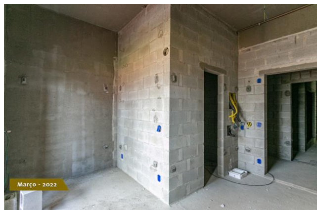
Foto 3 – Conduítes elétricos em alvenaria.
