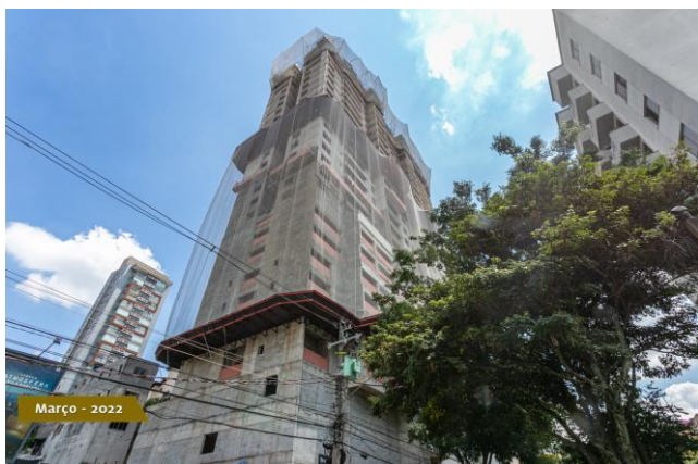
Foto 1 – Fachada do edifício.
