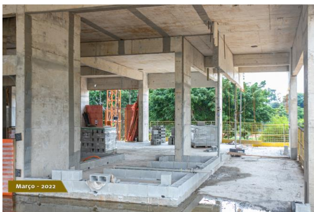
Foto 3 - Blocos alocados para construção de alvenaria.
