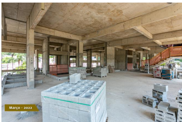
Foto 1 - Blocos alocados em canteiro de obra.
