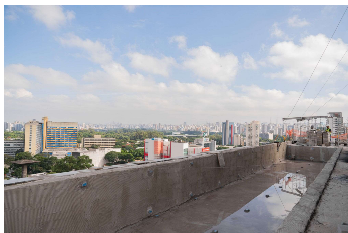
Foto 2 - Acabamentos em área do roof top.
