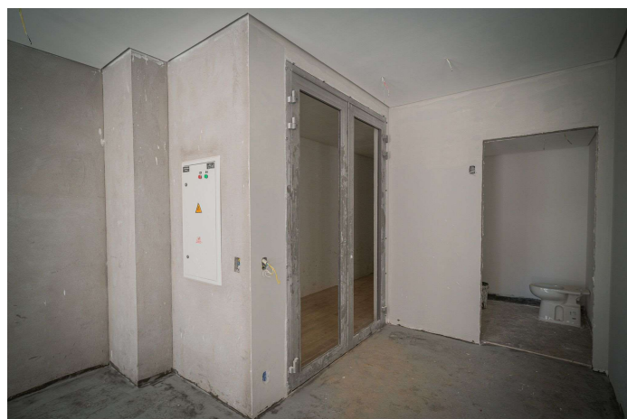
Foto 4 – Fase de acabamentos em unidade não residencial.
