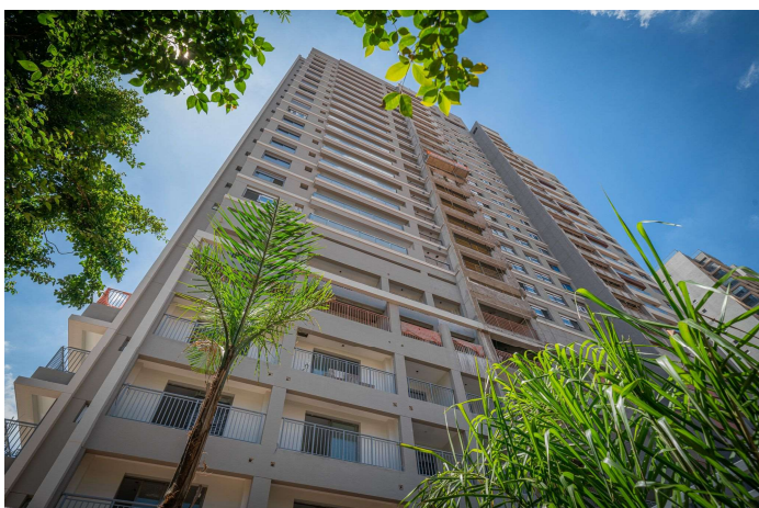
Foto 1 – Vista da fachada.
