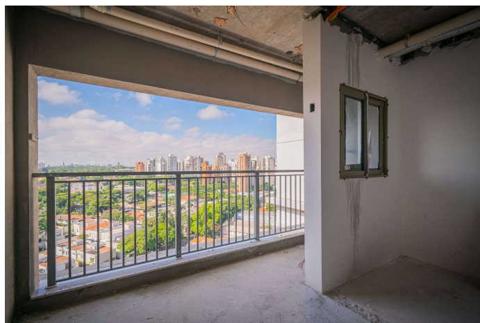
Foto 4 – Fase de acabamentos em unidade não residencial.
