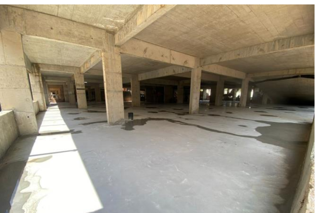
Foto 4 - Visão interna piso térreo.
