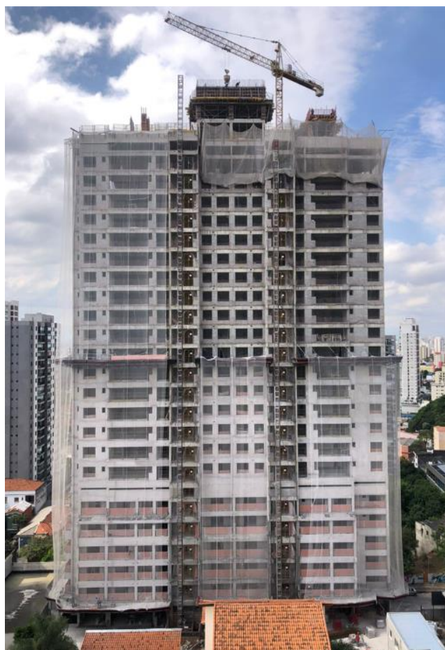
Foto 1 - Visão lateral do edifício.
