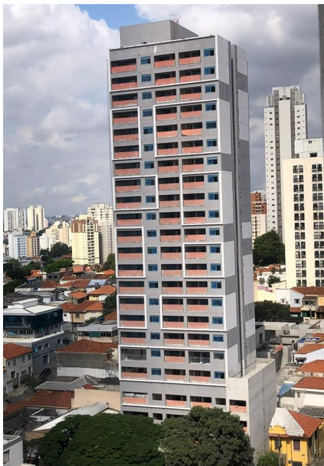
Foto 1 - Fachada do empreendimento com 20 pavimentos construídos e acabamento externo iniciado.
