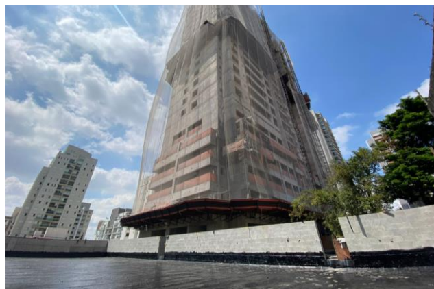
Foto 2 - Impermeabilização de laje.
