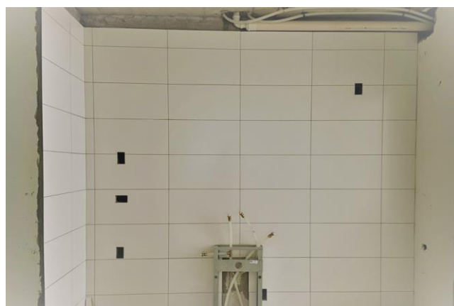
Foto 2 - Acabamento com azulejos em área molhada.
