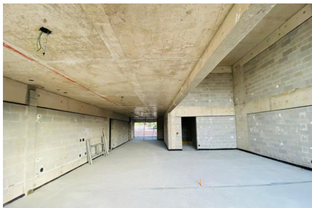
Foto 2 - Visão interna piso térreo.
