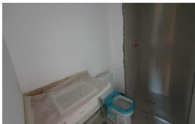
Foto 3 - Instalação das áreas molhadas.
