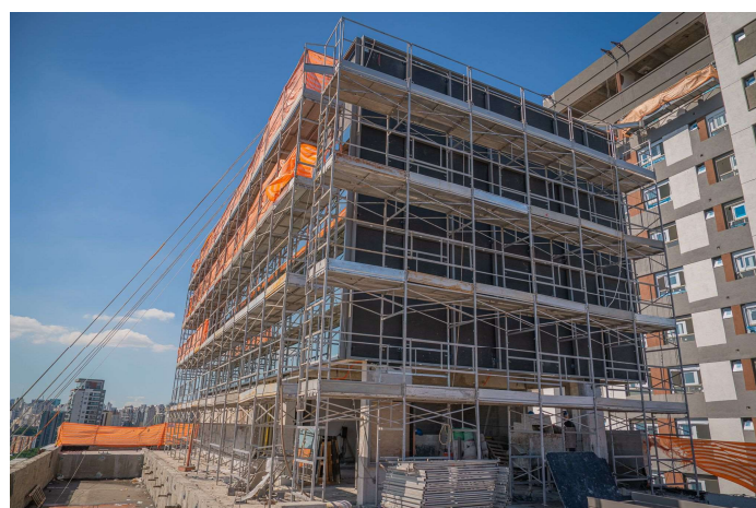
Foto 2 - Vista lateral da obra com andaimes.
