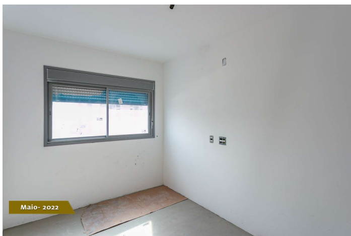
Foto 1 – Esquadria de unidade instalada
