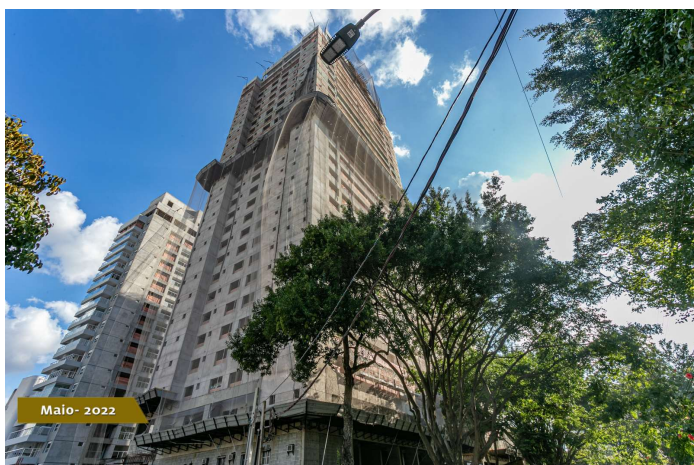
Foto 1 –Vista lateral de fachada.
