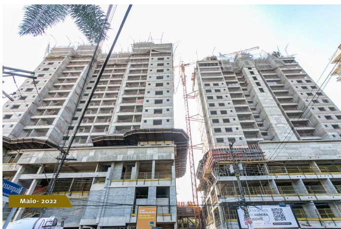
Foto 1 – Vista frontal da obra.
