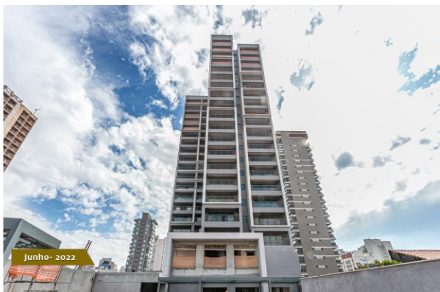
Foto 1 – Fachada do empreendimento.
