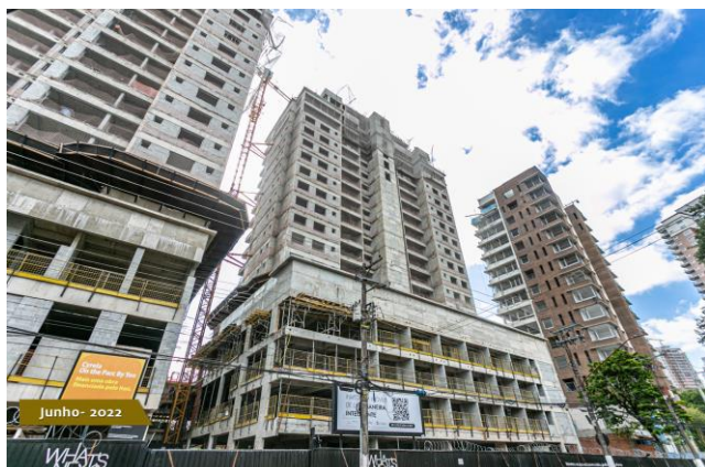
Foto 1 - Vista frontal da obra.
