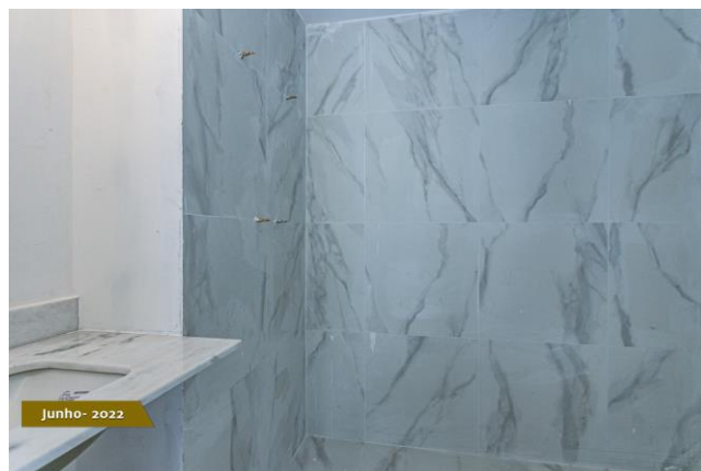
Foto 4 - Paredes internas com revestimento nos banheiros.
