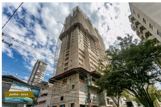
Foto 1 – Visão lateral do edifício.
