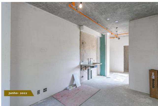
Foto 3 - Tubulações hidráulicas e aplicação de revestimento.
