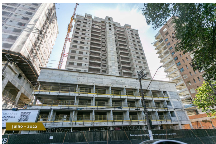
Foto 1 – Vista frontal da obra.
