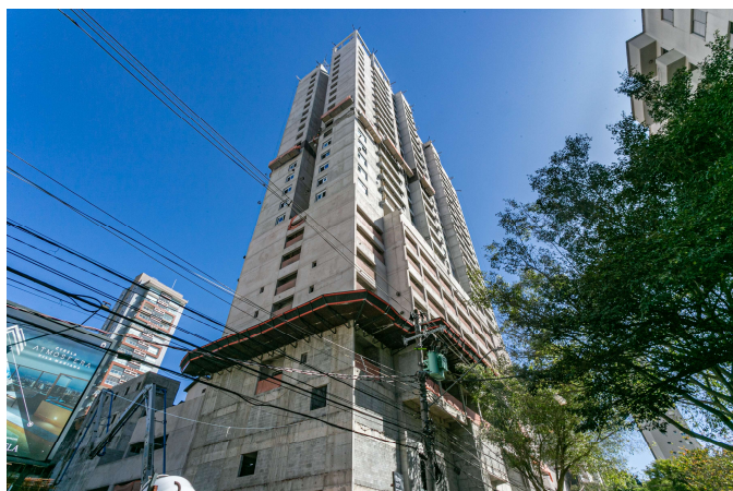
Foto 1 – Visão lateral do edifício.
