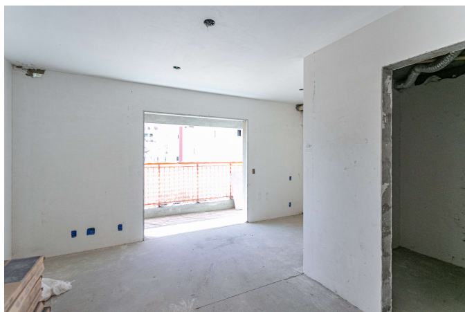
Foto 3 – Paredes com acabamento de massa corrida.
