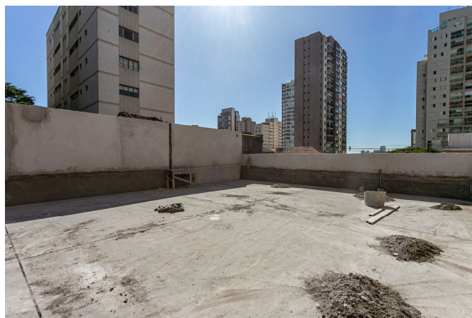
Foto 2 – Nivelamento após impermeabilização de laje.
