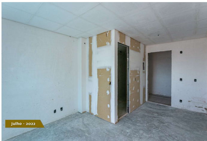
Foto 3 – Acabamentos em gesso e massa corrida.
