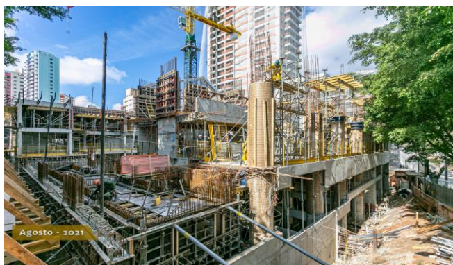
Foto 1 – Armações de aço e concretagem.
