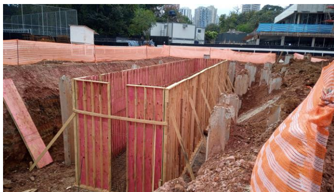
Foto 3 - Construção da fundação com a montagem dos moldes e colocação dos vergalhões de aço.
