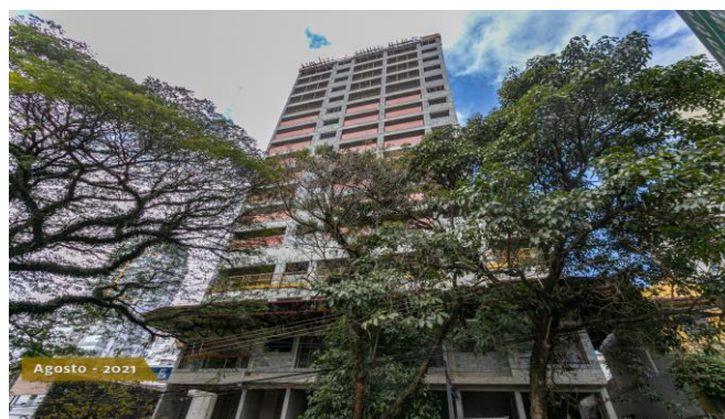
Foto 3 - Fachada do empreendimento com 13 dos 19 pavimentos construídos.
