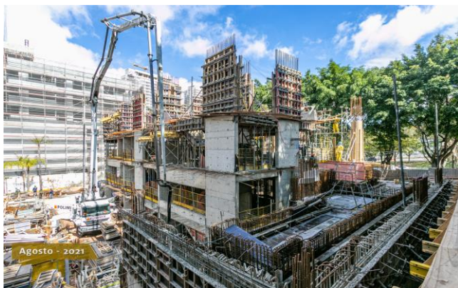
Foto 3 – Armações de aço e concretagem.
