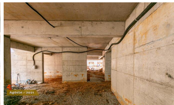
Foto 4 – Pilares, vigas e paredes finalizadas.
