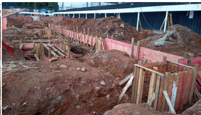
Foto 2 – Estruturas de contenção do edifício com a montagem dos moldes e colocação dos vergalhões de aço.
