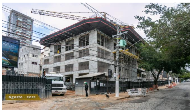
Foto 1 – Fachada do edifício com início de construção do quarto pavimento.
