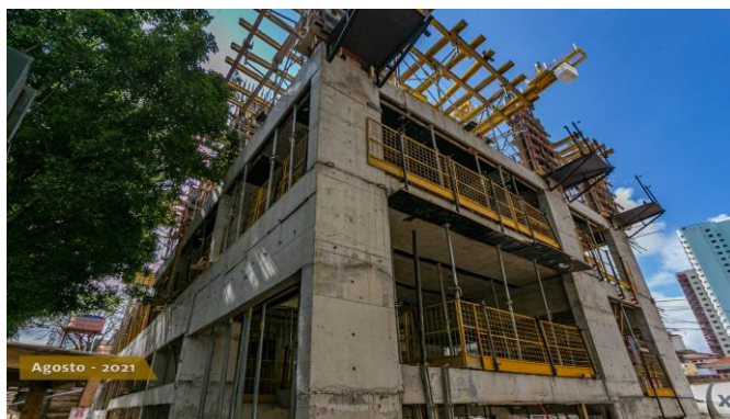
Foto 2 – Início de construção do terceiro pavimento.
