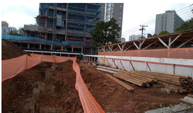
Foto 1 – Foram realizadas para a acomodação das estacas pré-moldadas no terreno.
