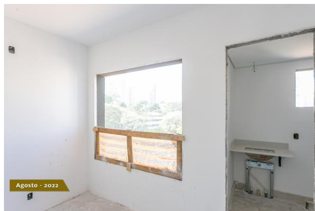
Foto 4 – Acabamento com massa corrida em unidade não residencial.
