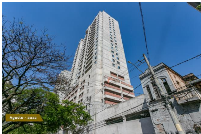
Foto 1 – Visão lateral do edifício.
