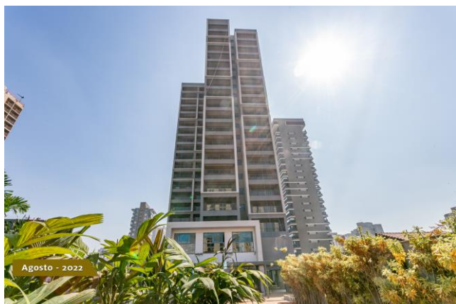
Foto 1 – Fachada do empreendimento.
