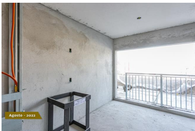
Foto 4 – Área interna de unidade não residencial.
