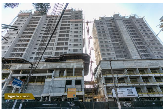
Foto 1 – Vista frontal da obra.
