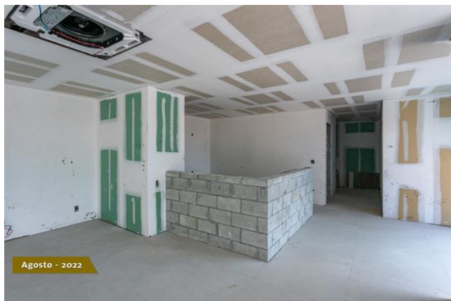
Foto 3 – Acabamentos em gesso e massa corrida.
