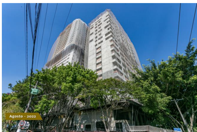
Foto 1 – Vista lateral de fachada.
