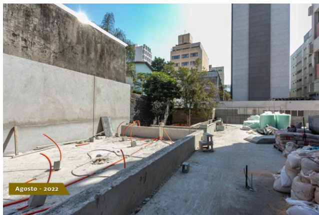
Foto 2 – Instalação de dutos elétricos em área externa.
