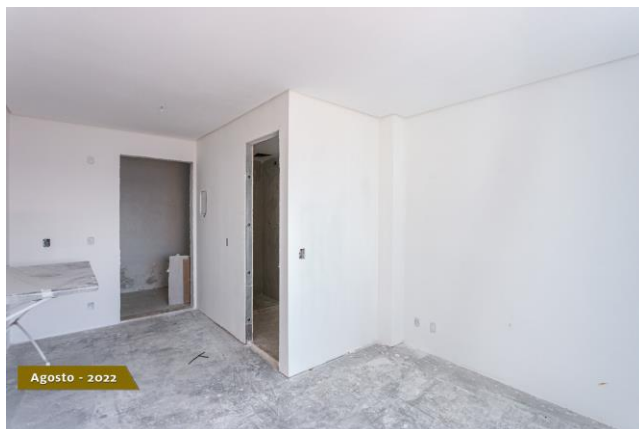
Foto 4 – Acabamentos em gesso e massa corrida.
