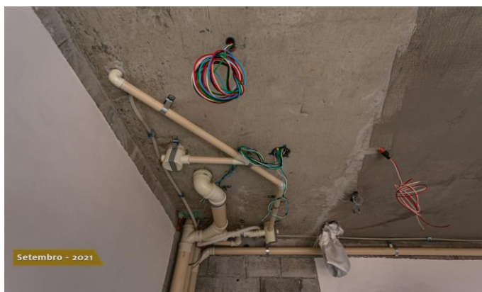
Foto 2 - Instalações hidráulicas e elétricas.
