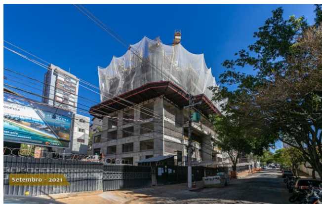
Foto 1 – Fachada do edifício com início de construção do sexto pavimento.
