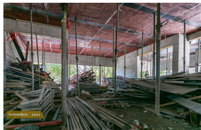
Foto 4 – Escoramento de laje em pavimento.
