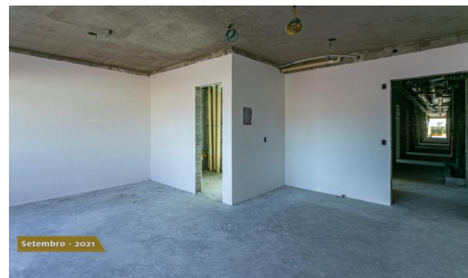
Foto 4 - Unidade com acabamento de massa corrida aplicada em parede.
