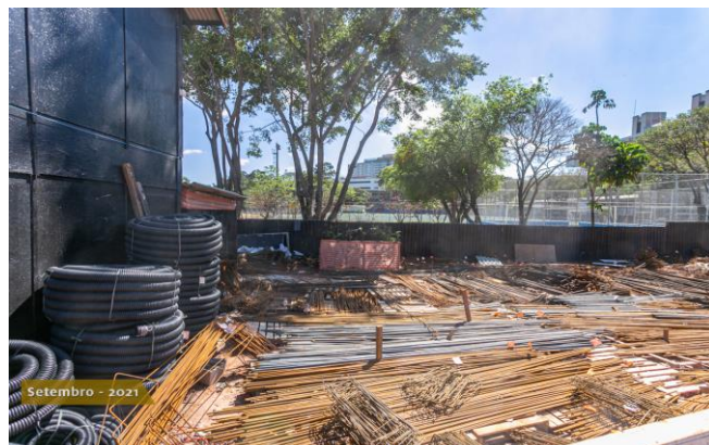
Foto 2 - Vergalhões de aço acomodados em obra
