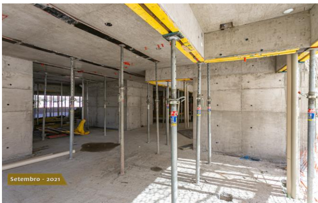
Foto 3 – Escoramento de viga em pavimento.
