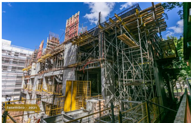
Foto 1 – Armações de aço e moldes para concretagem de sistema estrutural.
