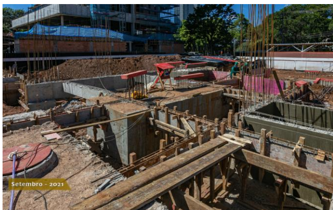
Foto 3 - Fundação em concreto armado
