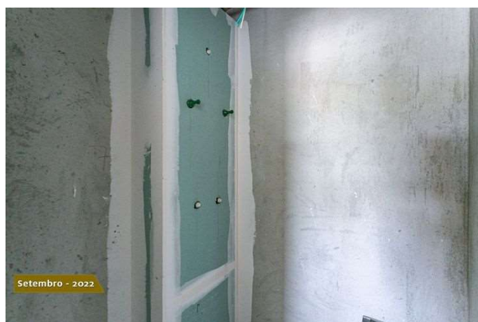
Foto 4 – Acabamento e hidráulica em unidade não residencial.
