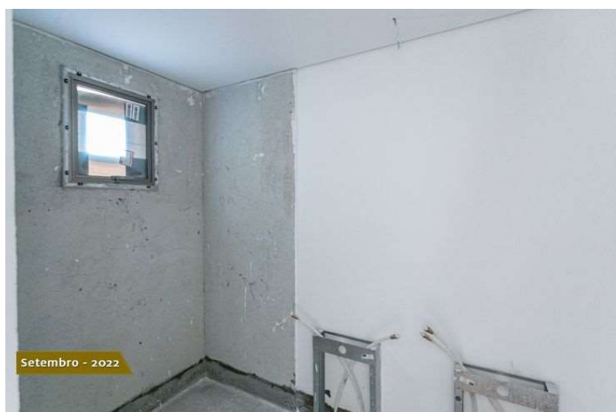
Foto 3 - Acabamentos com massa corrida e cabeamentos.
