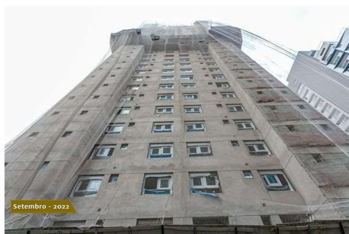
Foto 2 - Vista externa do edifício em construção.
