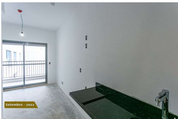
Foto 3 – Acabamentos em gesso e massa corrida.
