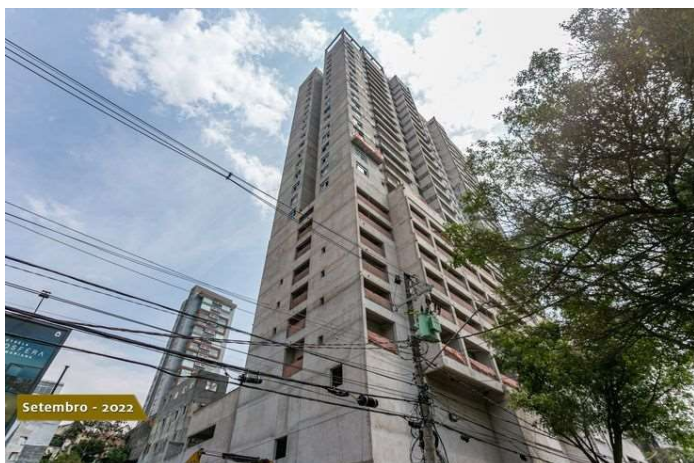
Foto 1 – Visão lateral do edifício.
