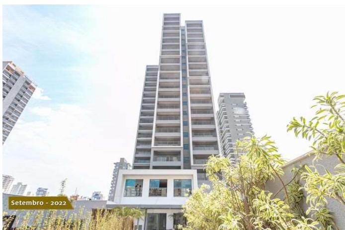
Foto 1 – Fachada do empreendimento.
