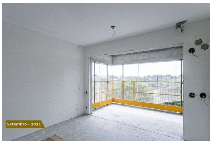
Foto 3 – Paredes com acabamento de massa corrida.
