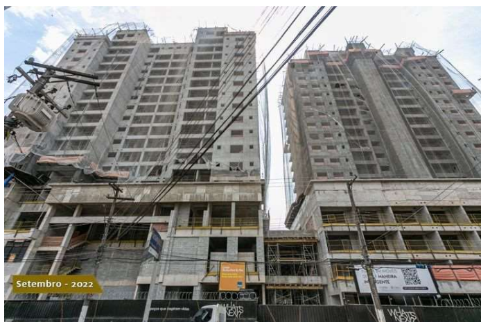
Foto 1 – Vista frontal da obra.
