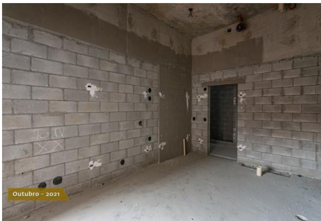
Foto 4 – Alvenaria de pavimento
