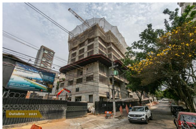
Foto 1 – Fachada do edifício com início de construção do oitavo pavimento.
