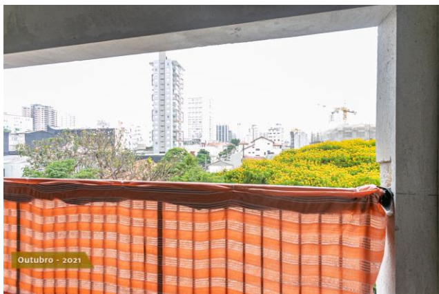
Foto 1 – Grade de contenção de sacada instalado.
