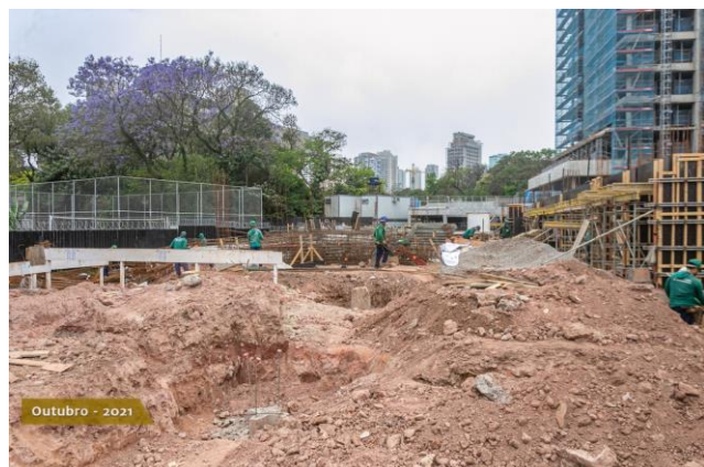
Foto 1 – Estrutura armada em terreno
