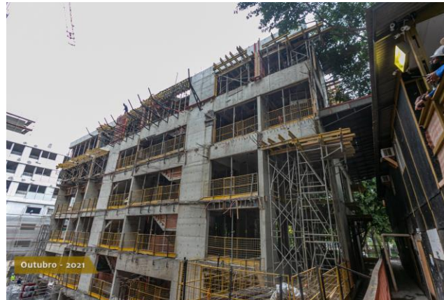
Foto 4 – Fachada da construção
