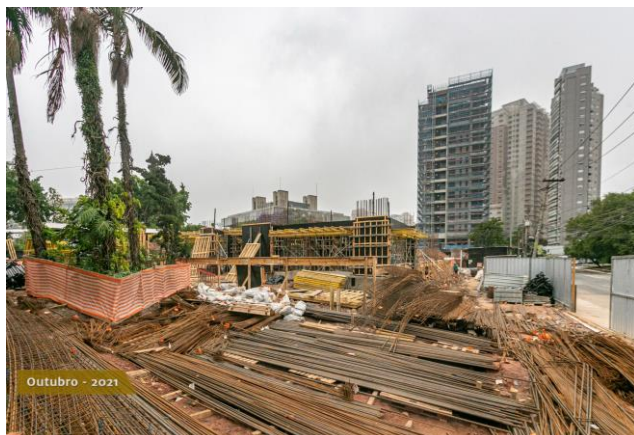
Foto 4 – Vergalhões alocados em canteiro de obra
