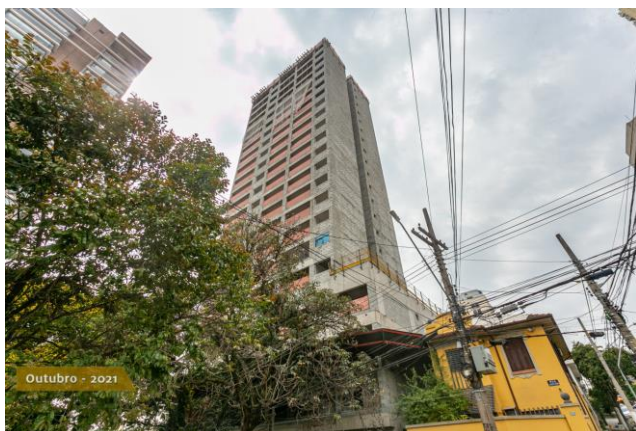
Foto 3 - Fachada do empreendimento com 18 dos 19 pavimentos construídos.
