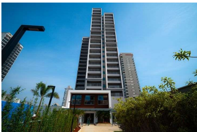
Foto 1 – Fachada do empreendimento.
