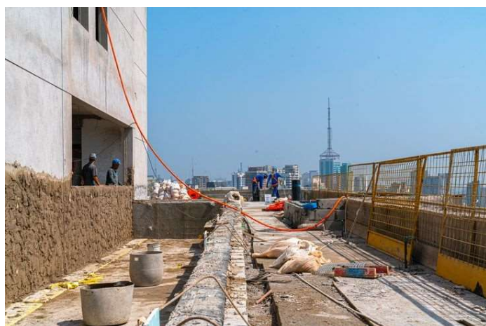
Foto 2 – Vista da parte superior do empreendimento.
