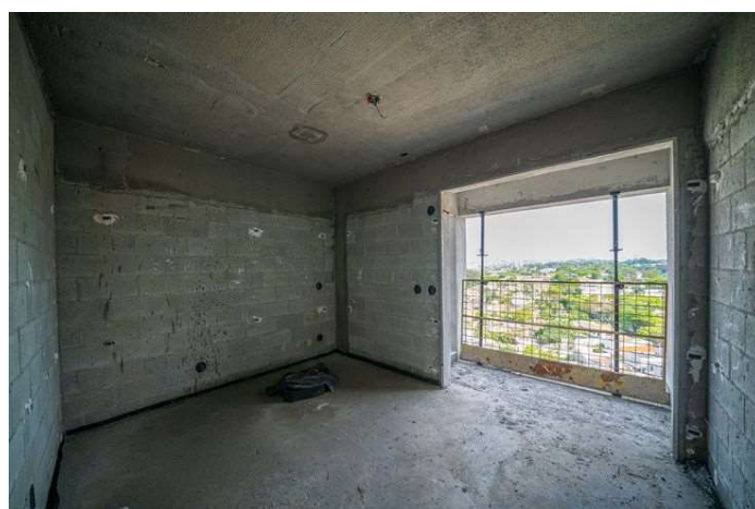
Foto 4 – Alvenaria em unidade não residencial.
