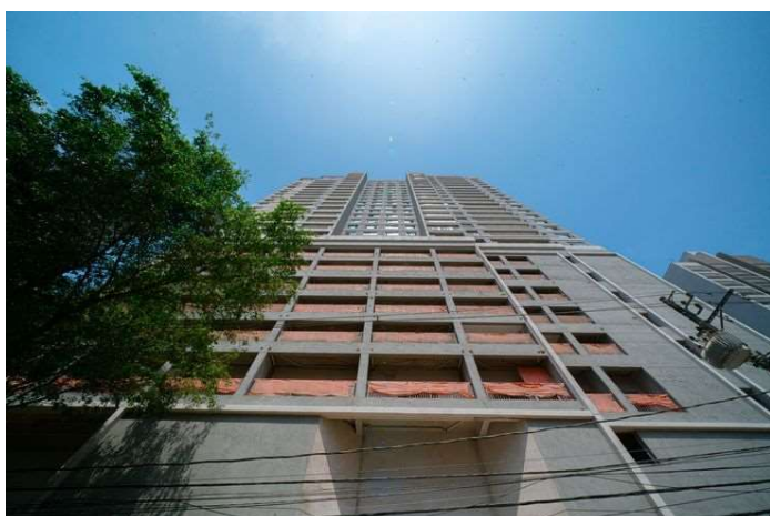
Foto 1 – Visão lateral do edifício.
