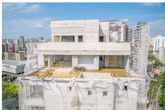
Foto 2 – Vista superior do empreendimento.
