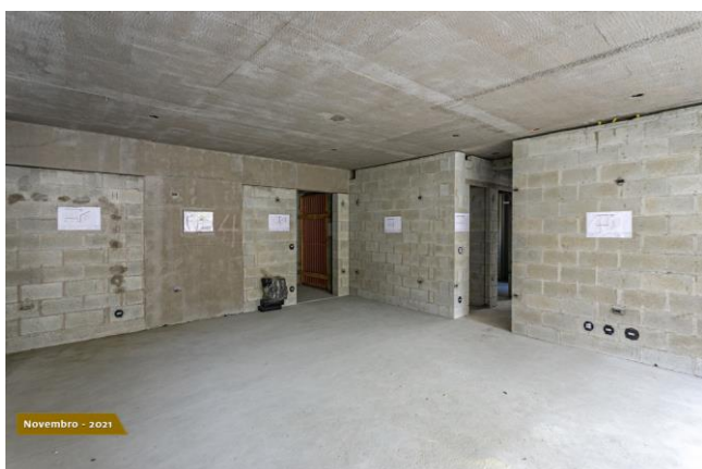
Foto 1 - Alvenaria em pavimento finalizada.
