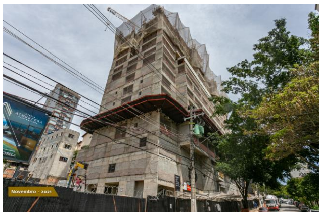
Foto 1 – Fachada do edifício com início de construção do décimo quarto pavimento.
