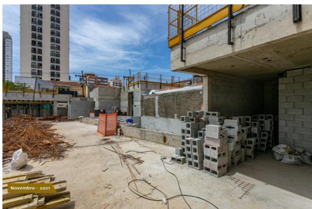
Foto 1 – Canteiro de obra.
