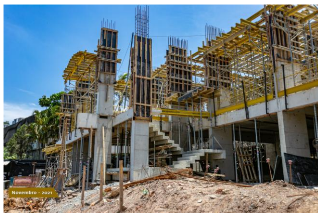
Foto 2 – Pilares em concreto armado do pavimento térreo acabados
