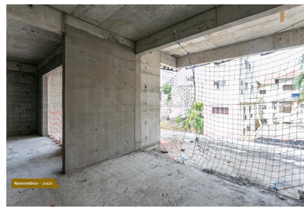
Foto 4 – Vão de sacada em pavimento
