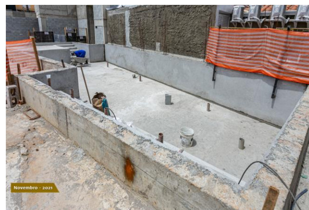
Foto 4 – Estrutura de piscina em área de lazer
