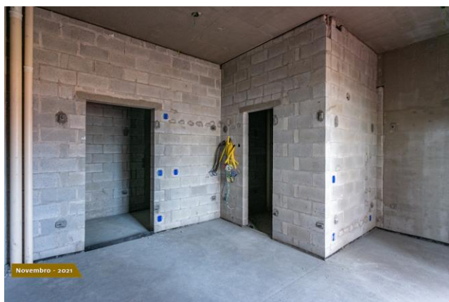
Foto 3 – Conduítes elétricos em alvenaria.
