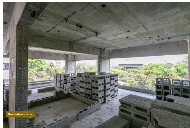
Foto 4 - Blocos de concreto alocados em pavimento
