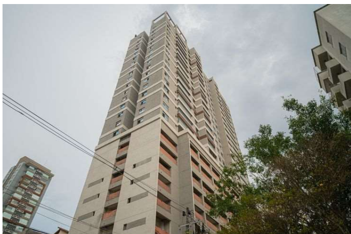
Foto 1 – Visão lateral do edifício.
