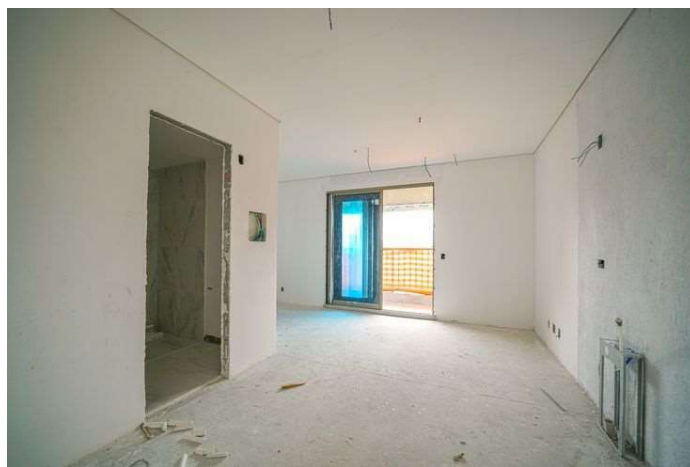
Foto 4 - Acabamento e massa corrida em unidade não residencial.
