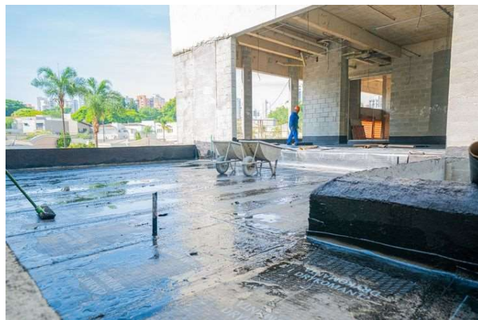
Foto 2 – Impermeabilização em área comum externa.
