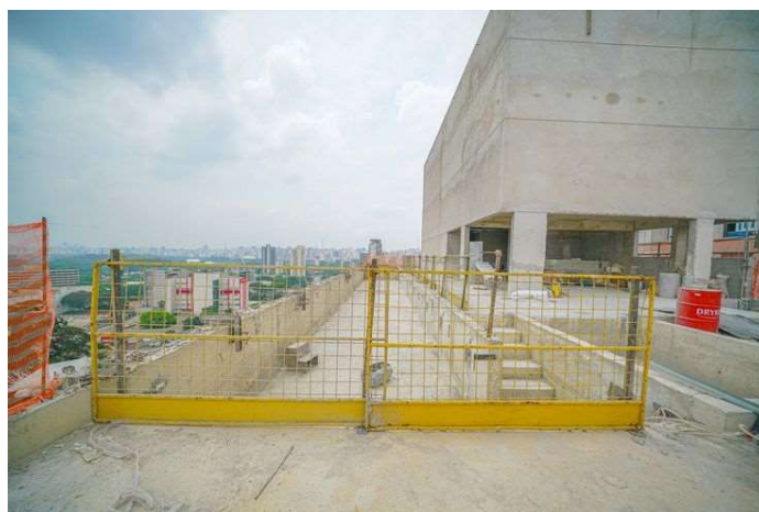
Foto 2 - Vista do roof top do edifício em construção.
