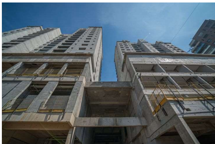
Foto 1 – Vista frontal da obra.
