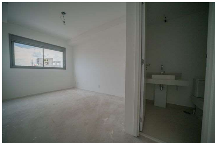
Foto 4 – Unidade NR com acabamentos e louça.
