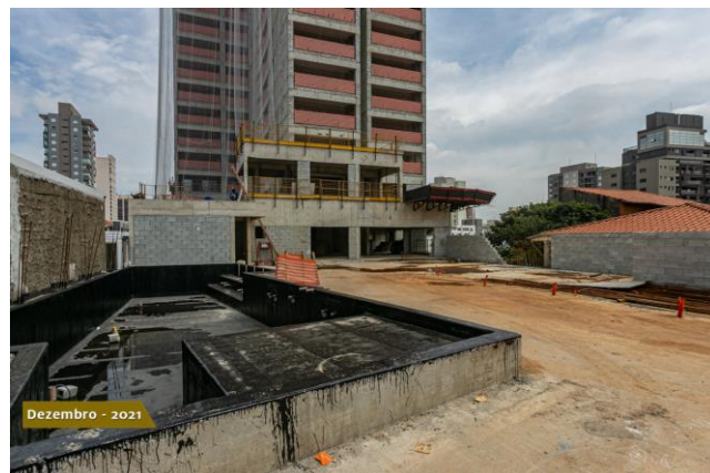
Foto 4 – Impermeabilização de piscina em área de lazer
