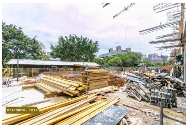
Foto 1 – Estrutura armada em terreno
