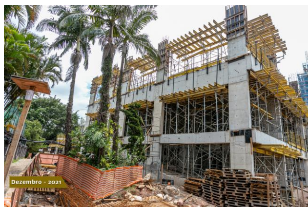
Foto 3 – Montagem de moldes para concretagem de estrutura em concreto armado
