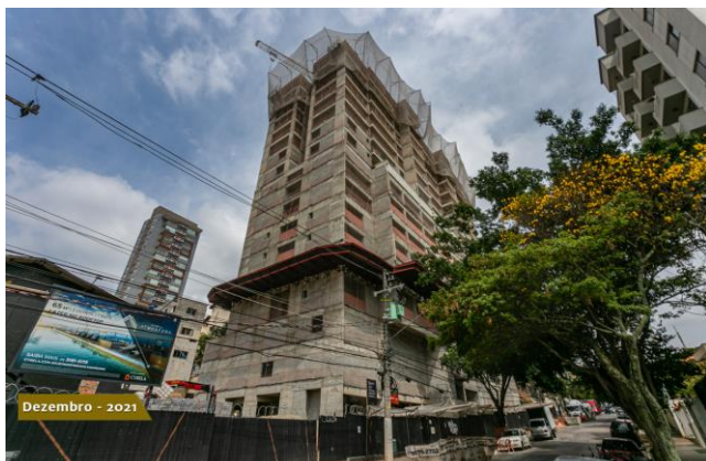
Foto 1 – Fachada do edifício com início de construção do décimo sétimo pavimento.
