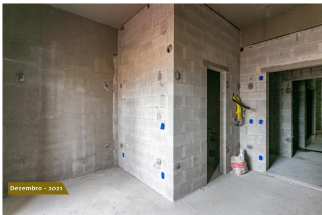
Foto 3 – Conduítes elétricos em alvenaria.
