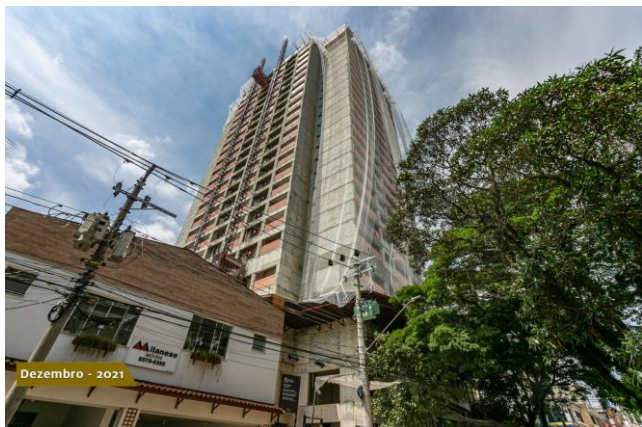
Foto 3 - Fachada do empreendimento com 19 pavimentos construídos.
