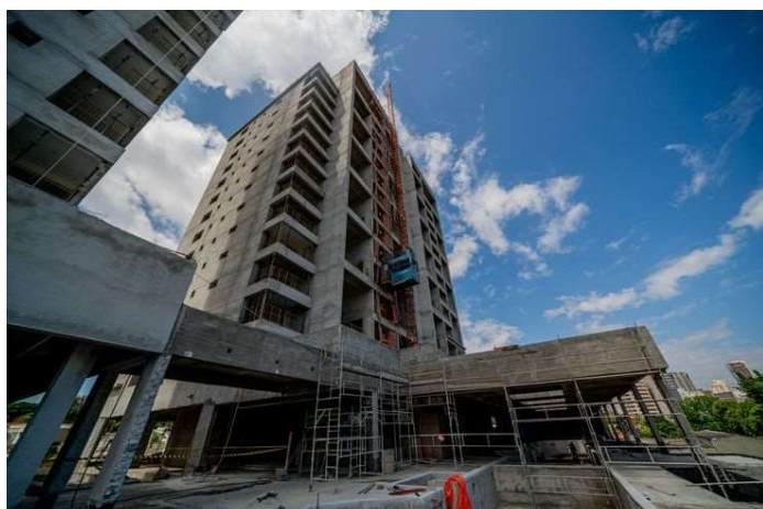
Foto 1 – Vista frontal da obra.
