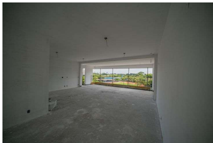
Foto 4 – Acabamento em massa corrida em unidade.
