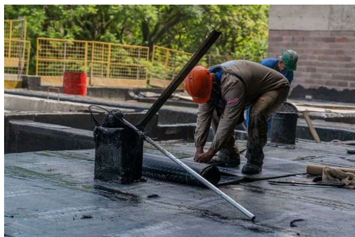
Foto 2 – Impermeabilização em área comum externa.
