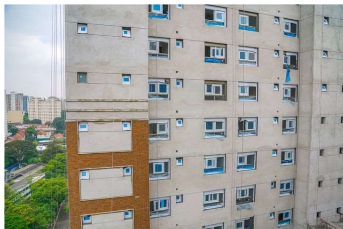
Foto 2 - Acabamentos externos do edifício em construção.
