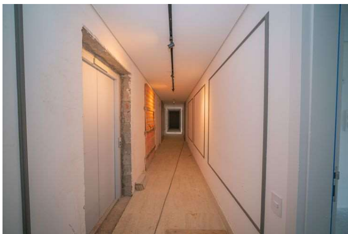
Foto 3 - Fase de acabamentos corredor interno.
