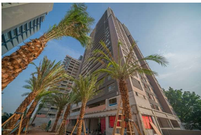
Foto 1 - Vista da fachada.
