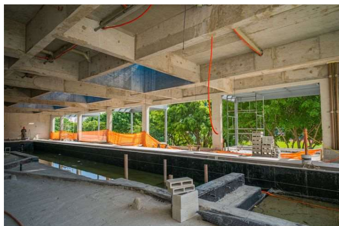
Foto 2 – Área comum em fase de testes de impermeabilização.
