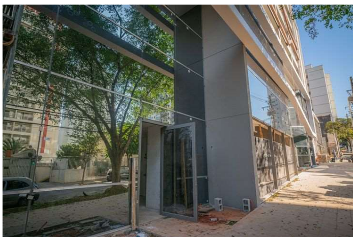
Foto 1 – Vista da fachada.
