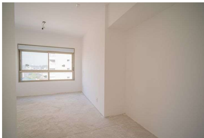
Foto 4 - Fase de acabamentos em unidade não residencial.
