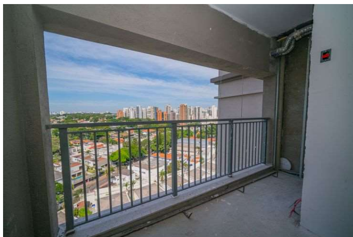
Foto 3 – Fase de acabamentos em unidade não residencial.
