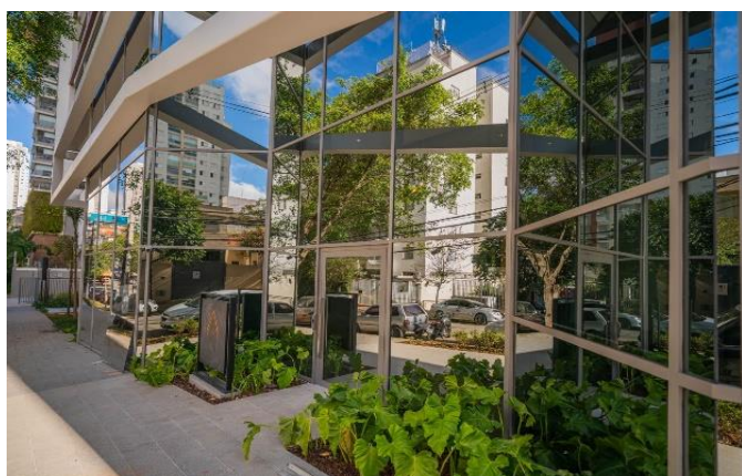
Foto 1 – Vista da fachada.
