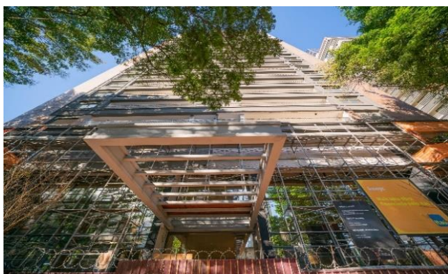
Foto 1 – Vista da fachada.
