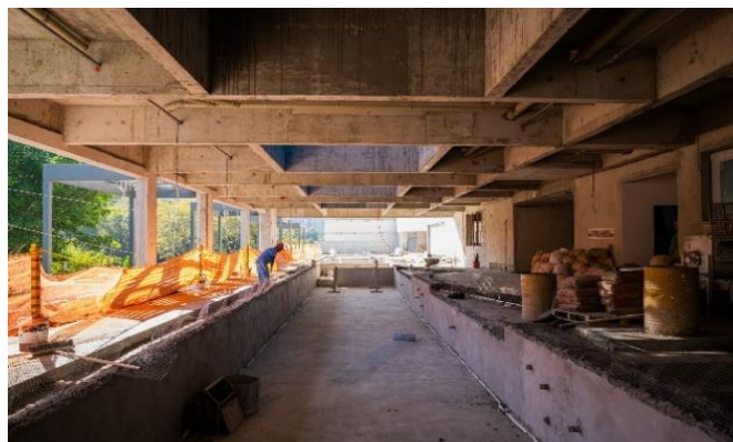
Foto 2 – Área comum com piscina em fase de acabamentos.
