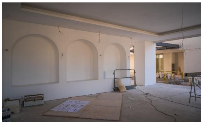
Foto 4 – Fase de acabamentos em área comum interna.
