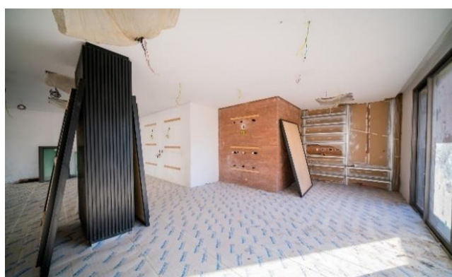
Foto 4 – Fase de acabamentos em unidade não residencial.
