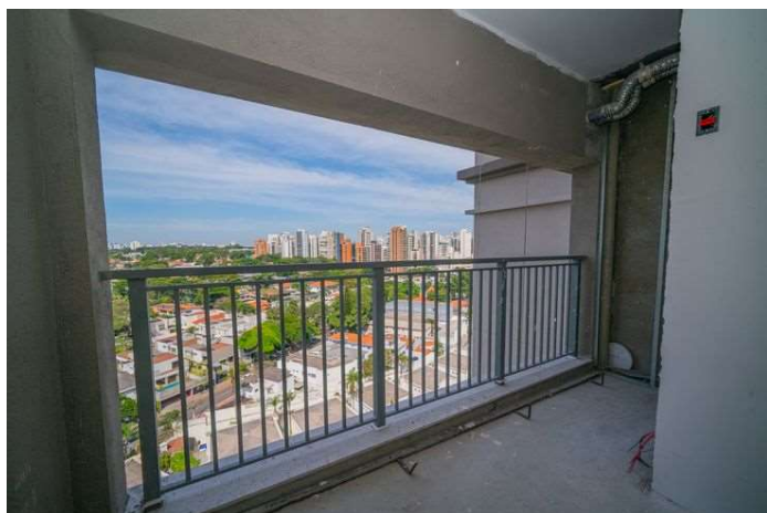
Foto 3 – Fase de acabamentos em unidade não residencial.
