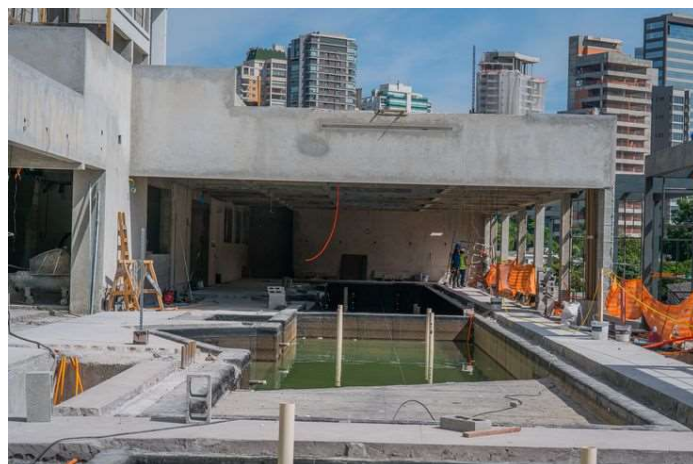
Foto 4 – Área comum em fase de testes de impermeabilização.
