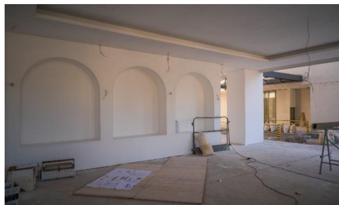
Foto 4 – Fase de acabamentos em área comum interna.
