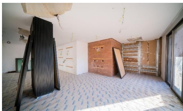
Foto 4 – Fase de acabamentos em unidade não residencial.
