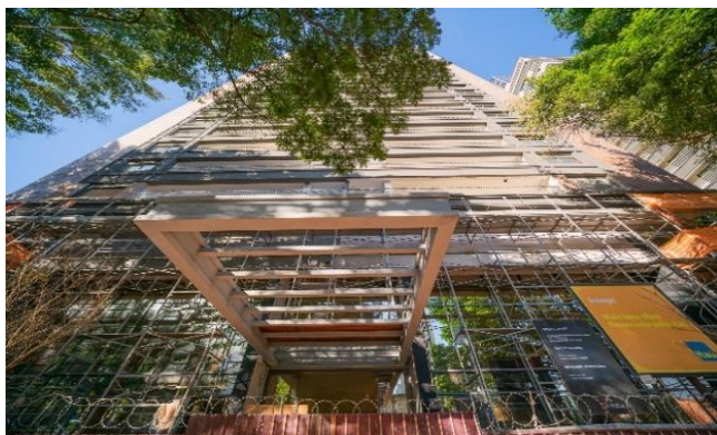
Foto 1 – Vista da fachada.
