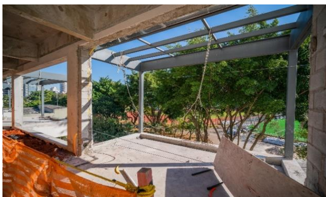
Foto 1 – Área comum externa nos fundos do empreendimento.
