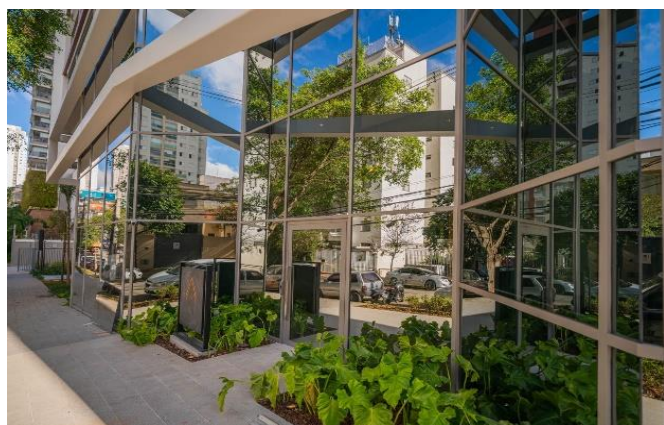
Foto 1 – Vista da fachada.
