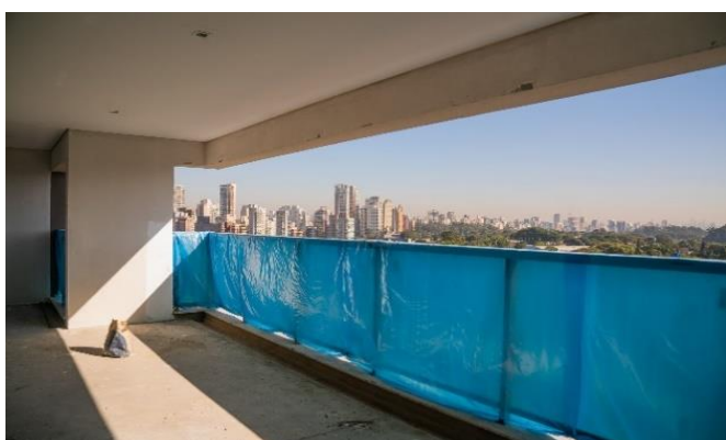
Foto 3 – Unidade não residencial.
