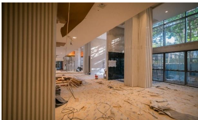
Foto 3 - Hall de entrada em fase de acabamento.
