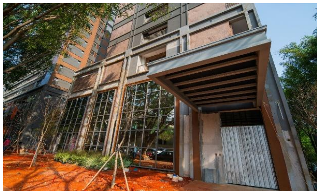
Foto 1 – Vista da fachada.
