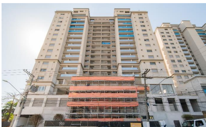
Foto 1 – Vista da fachada.
