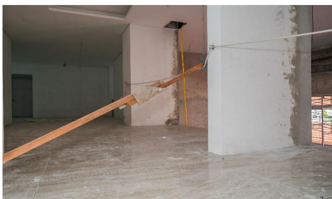
Foto 3 – Área comum em fase de acabamento.
