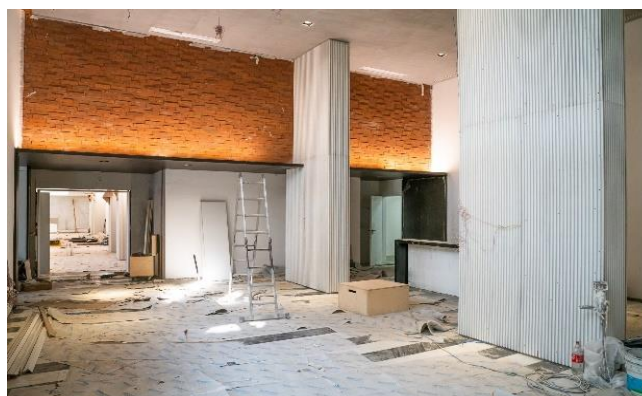
Foto 4 – Fase de acabamentos em área comum.
