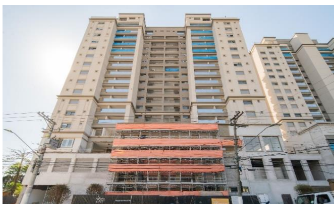
Foto 1 – Vista da fachada.
