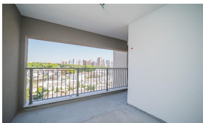
Foto 4 – Fase de acabamentos em unidade não residencial.
