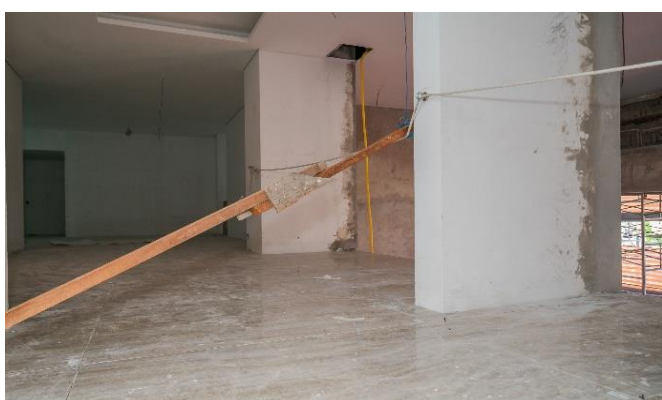
Foto 3 – Área comum em fase de acabamento.
