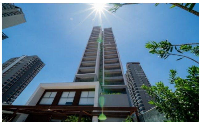
Foto 1 – Visão da fachada do empreendimento.
