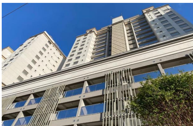
Foto 1 – Vista da fachada.
