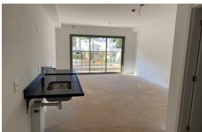
Foto 3 – Unidade não residencial.
