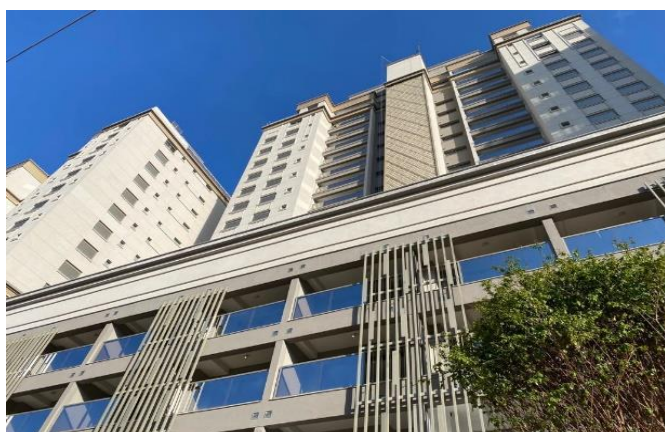
Foto 1 – Vista da fachada.
