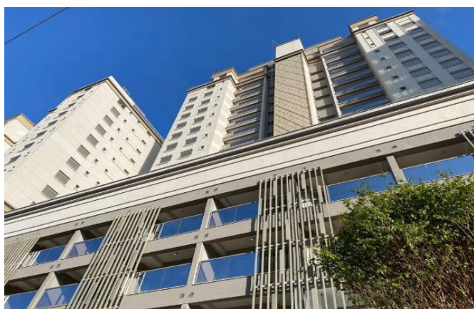
Foto 1 – Vista da fachada.
