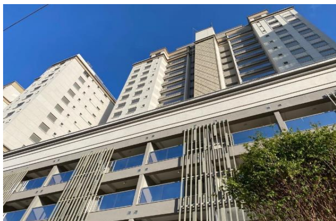
Foto 1 – Vista da fachada.
